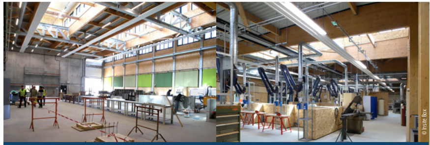
Une des nouvelles halles a été mise en service début 2023, y sont installées les formations STI2D, TISEC, TP et GO.
