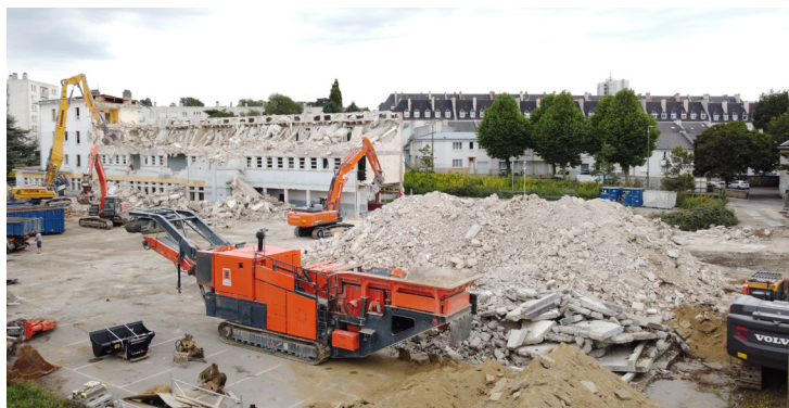
L'équivalent de 7 560 tonnes de béton ont été broyés sur site et réutilisés pour le terrassement
