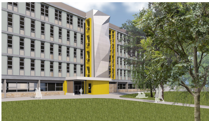
L'internat sera équipé d'un ascenseur et doté de chambres accessibles aux personnes à mobilité réduite © Athéna Architectes
