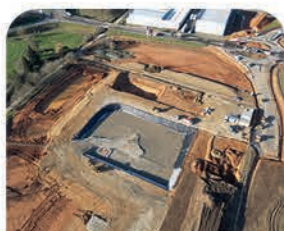
1 ER FÉVRIER Début des travaux de la station Biogaz Marches de Bretagne à Maen Roch
