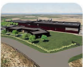
5 DÉCEMBRE Début des travaux de la nouvelle unité de production Mytilimer #Kerbone à Cancale
