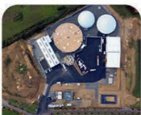
2 DÉCEMBRE Finalisation des travaux de l'unité de méthanisation Enerfées à Janzé
